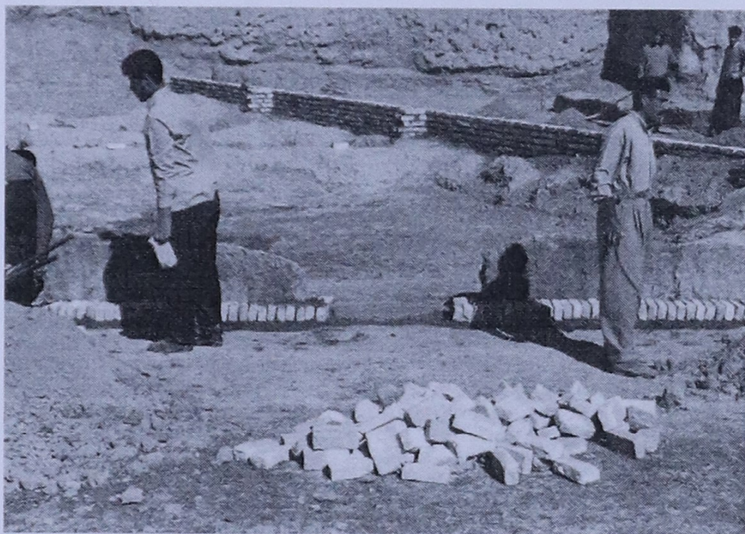
تصویر ۴۲- واحد A گونه چیدمان پشت دیوار (L-142) برای استواری بیشتر
