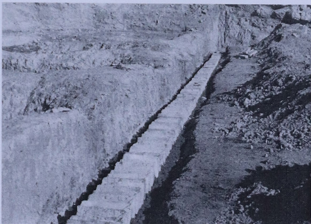
تصویر ۴۱- واحد A- گونه‌ی چیدمان نخستین رج آجر برای باز سازی دیوار
